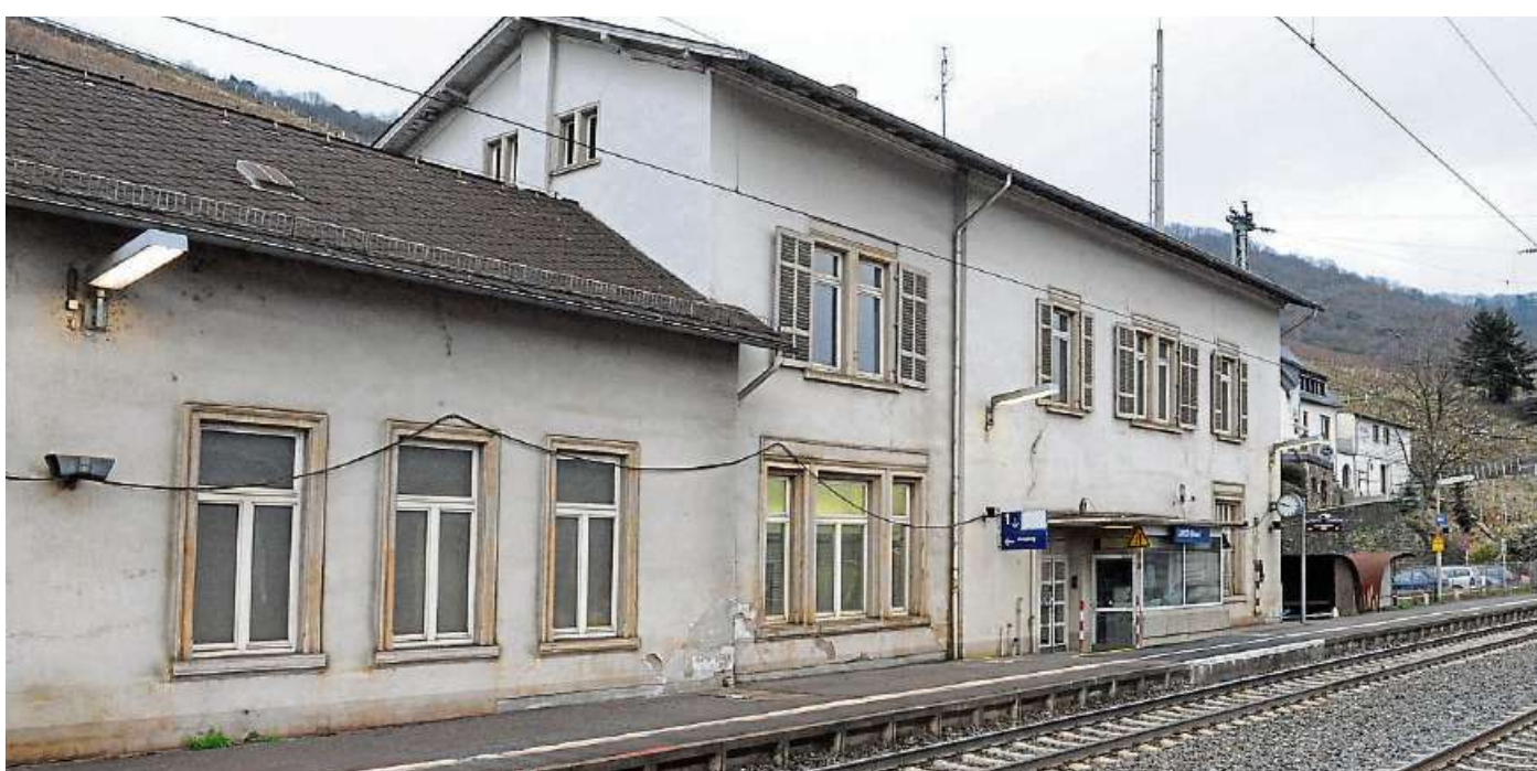
Der 1860 erbaute Lorcher Bahnhof, der unter Denkmalschutz steht, ist schon von außen keine Augenweide. Archivfoto: RMB/Heinz Margielsky
